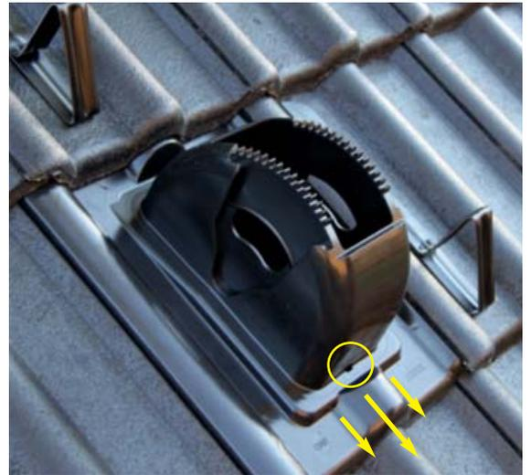
In der Bildmitte oben kann man gut erkennen, wie viel Kondenswasser sich im Entlüfterrohr und in der Grundplattenkuppel bildet, das zuverlässig über das Dach abgeleitet wird und sich im Winter in Form von Eisschollen zeigt.
